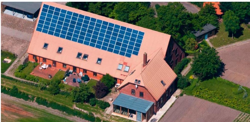
In diesem Mehrfamilienhaus nördlich von Hamburg versorgt eine 30-kWp-PV-Anlage sowie ein hocheffizientes BHKW mit 7,5 kW elektrischer Leistung acht Wohnungen und eine Werkstatt über eine Kaskadenmessung (siehe Infobox auf Seite 36) im Rahmen einer Lohnverstromung durch den Hauseigentümer. Der Strombezug aus dem Netz konnte mit beiden Anlagen zusammen um 90 Prozent reduziert werden.
