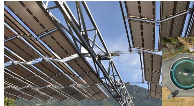
Beispiel: Faltdach der Kläranlage ARA Chur
